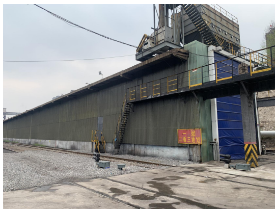
火车卸料间封闭厂房
