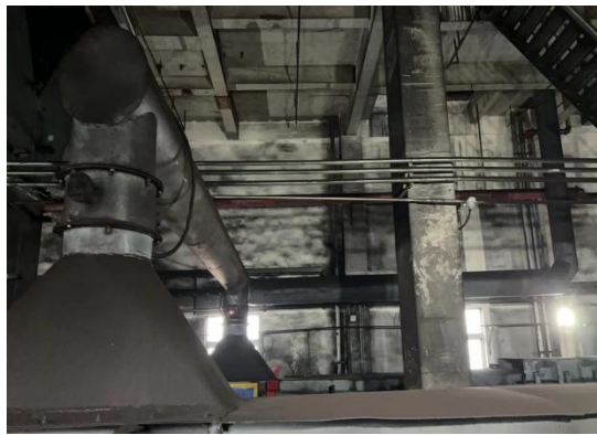
贮配煤筒仓仓上转载 2 废气
