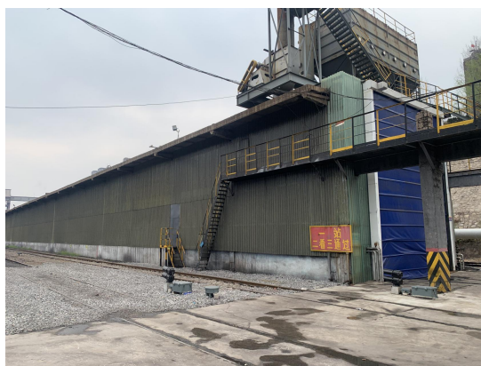
火车卸料间封闭
