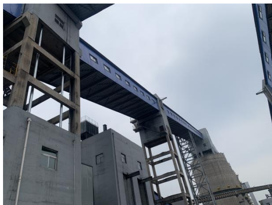
物料运输封闭廊道
